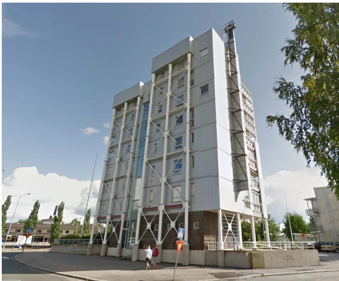
Kuva 19. Terästalo (Google Streetview).
